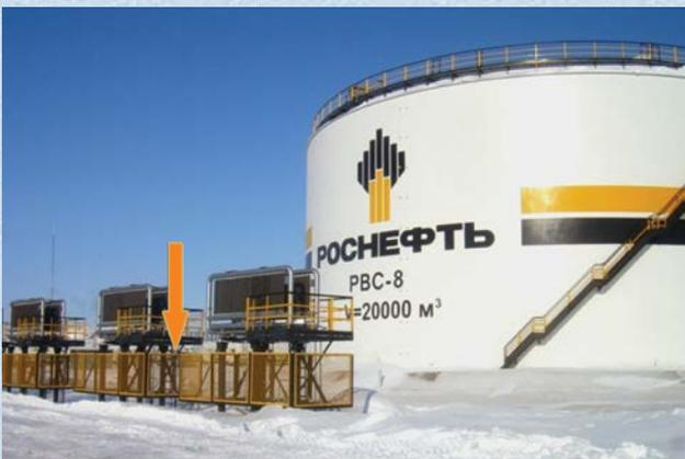
*Системы ГЕТ на Ванкорском нефтегазовом месторождении*
