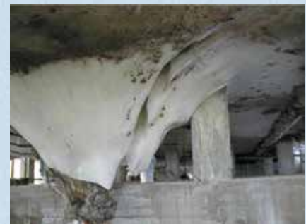
Рис. 1. Наледи, образуемые в проветриваемых подпольях зданий в результате аварийных утечек воды из водонесущих коммуникаций
