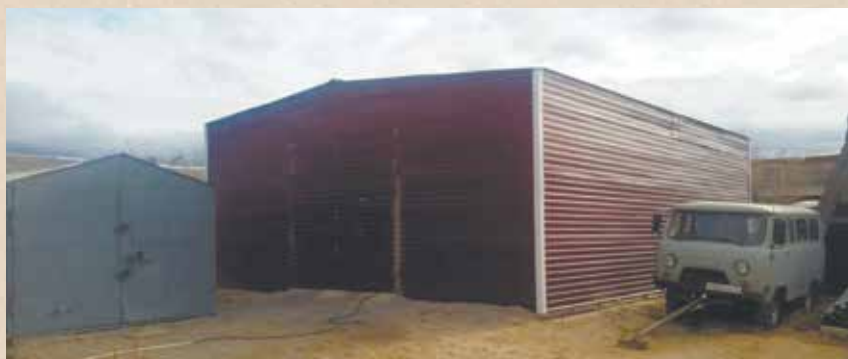
Опытное помещение (гараж) с устройством для его обогрева за счёт теплоты фазового перехода воды
