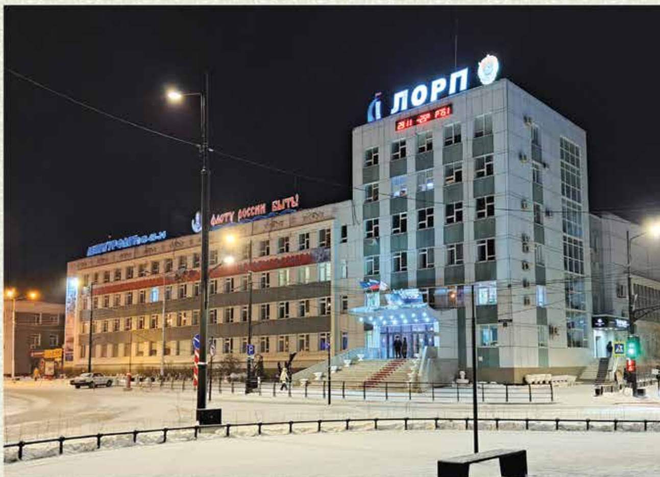
Ленское объединённое речное пароходство, г. Якутск. Здание построено в 1971 г.
