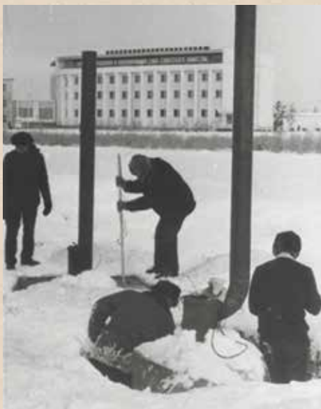
Испытание воздушных замораживающих установок на озере Круглом в г. Якутске
