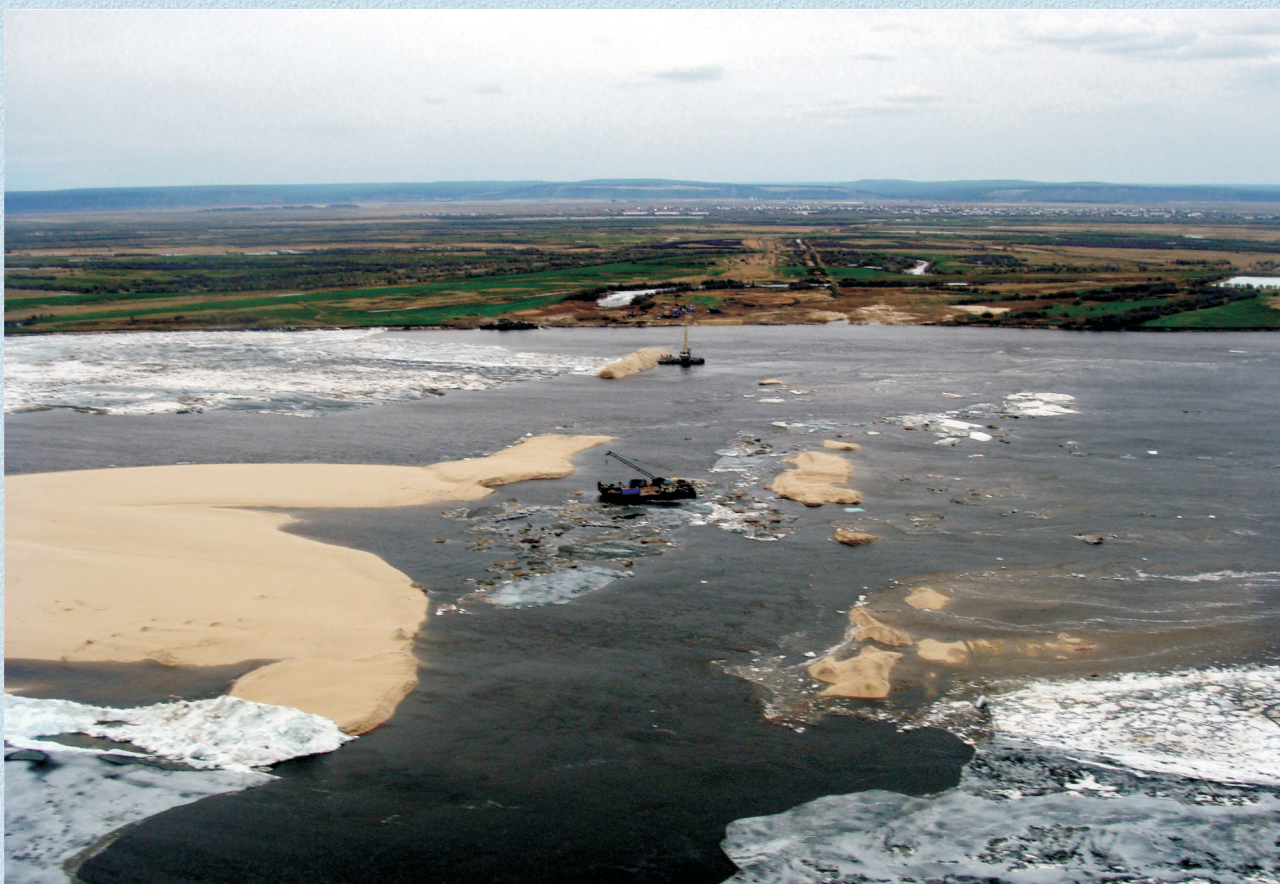
Рис. 2. Намывные работы в створе подводного перехода магистрального газопровода через р. Лену, способствовавшие формированию 20 мая 2010 г. исторического (повторяемость 1 раз в 100 лет) заторного подъема уровня воды у пос. Табага и небывалому наводнению в Хангаласском улусе РС(Я) [8]
