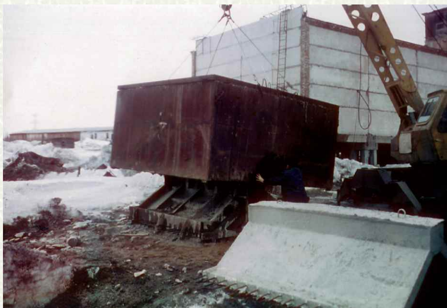
Рис. 5. Съем пропарочного колпака.
