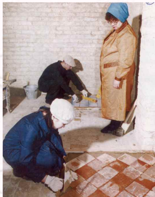
Занятия по отделочным работам на строительном факультете ЯГИТИ.
