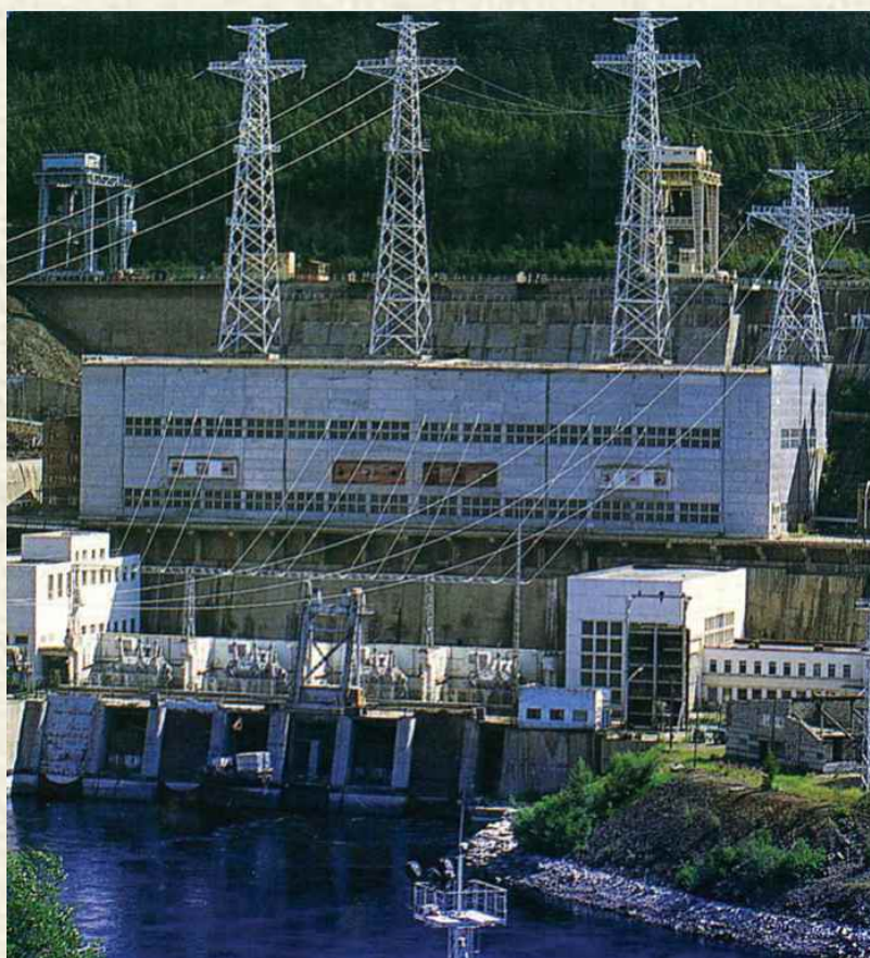
Первая в мире каменно-набросная плотина Вилуйской ГЭС-1 (1966 г.).
