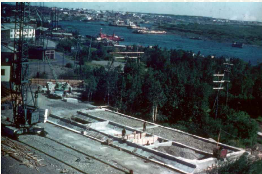
Рис. 6. Общая панорама строительства сборно-монолитной конструкции фундамента-оболочки под лабораторный корпус.
