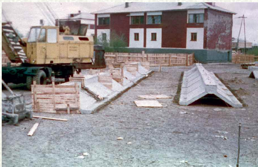
Рис. 3. Смонтированные складки фундамента-оболочки под жилой дом.
