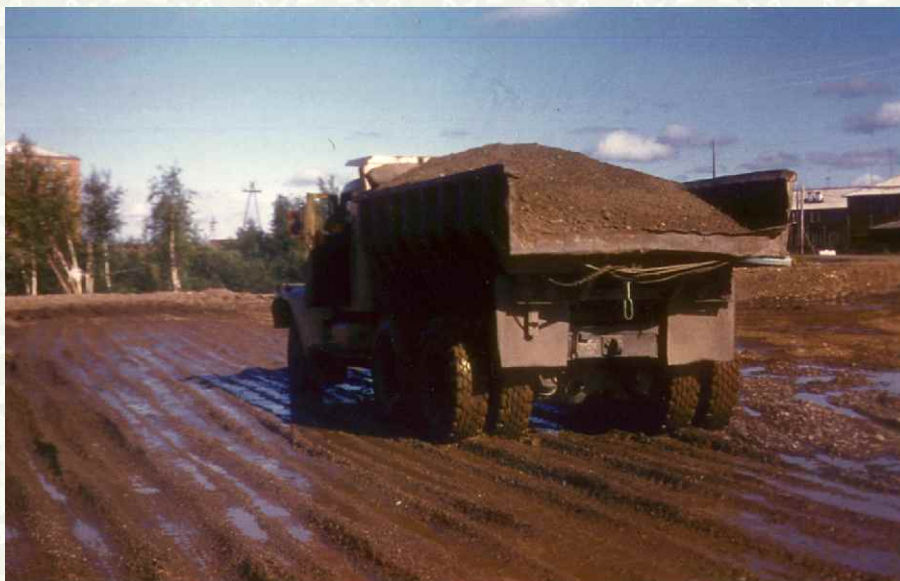
Рис. 2. Процесс уплотнения очередного промежуточного слоя.
