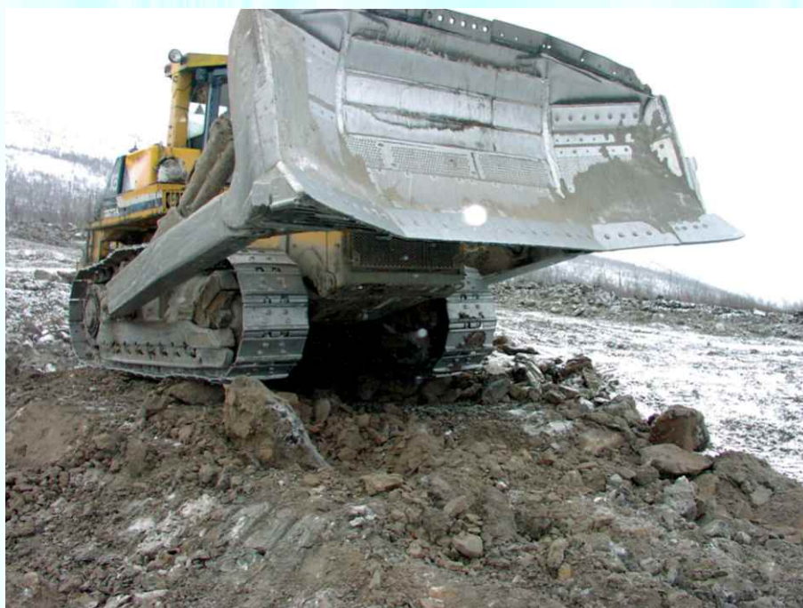
Тяжелый бульдозер «Комацу» – основная техника при проведении вскрышных работ на прииске.
