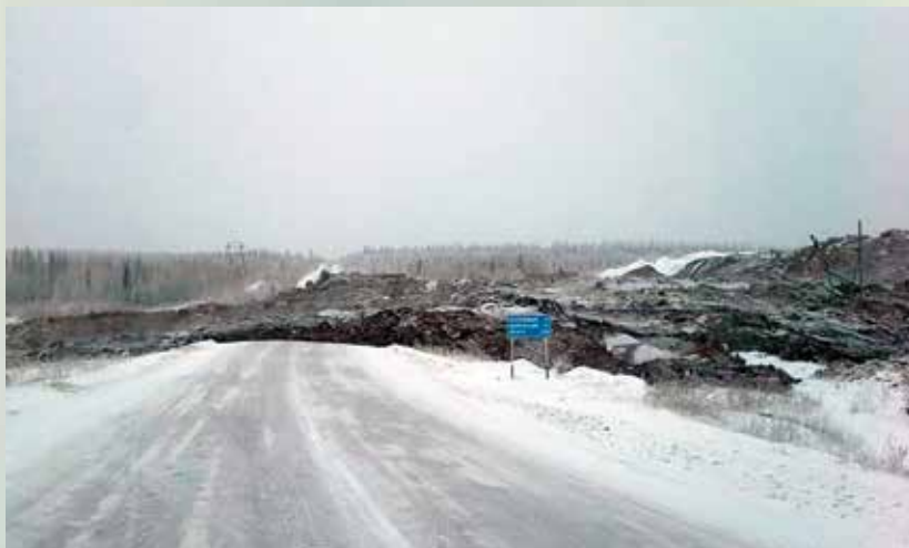
Оползень с территории неэксплуатируемой обогатительной фабрики № 5 АК «АЛРОСА» на трассе Мирный – Ленск, повредивший линию электропередачи (2015 г.) ( https://news.sputnik.ru/ )
