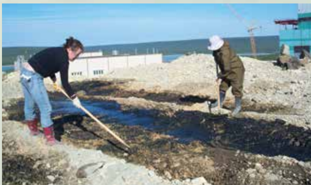
Применение осадков КОС при рекультивации на отвалах Айхальского ГОКа
