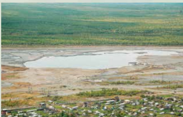
Хвостохранилище обогатительной фабрики № 3 Мирнинского горно-обогатительного комбината
