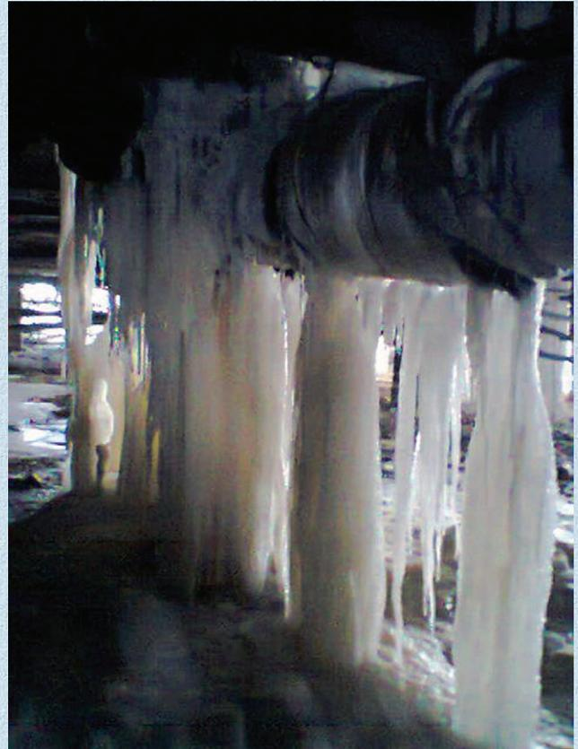
**Рис. 10. Ледяные бразования под южным углом главного корпуса.**
