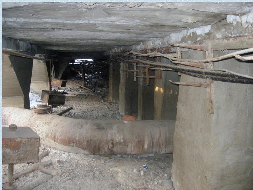
**Рис. 1. Проветриваемое подполье под юго-восточной частью главного корпуса.**
