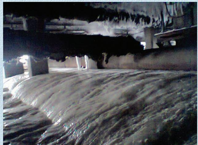
**Рис. 11. Наледь под главным корпусом вблизи скважины 53.**
