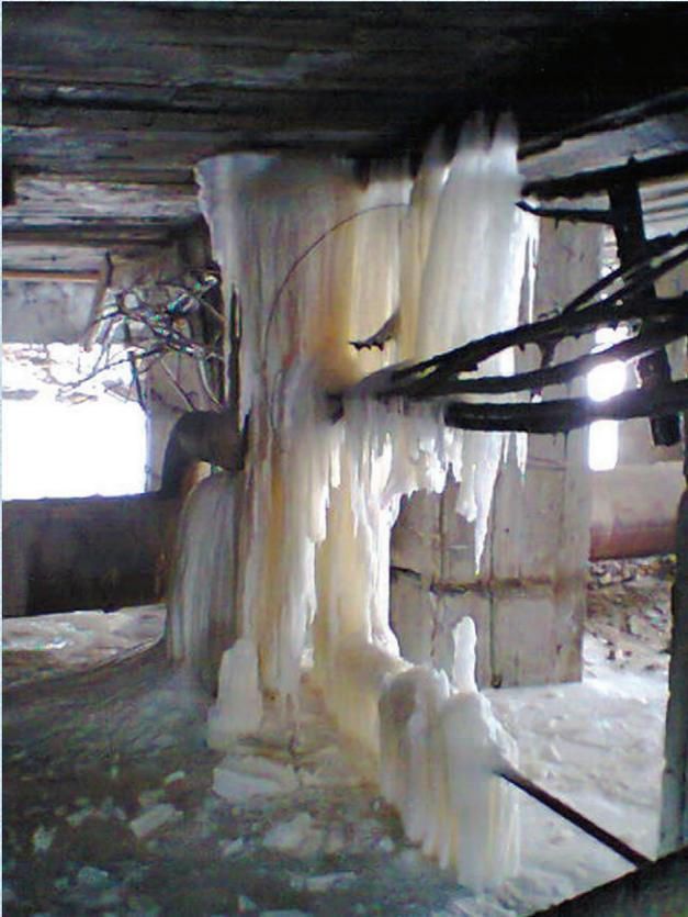
**Рис. 9. Ледяные натёки под южной частью главного корпуса между скважинами 53 и 2м.**
