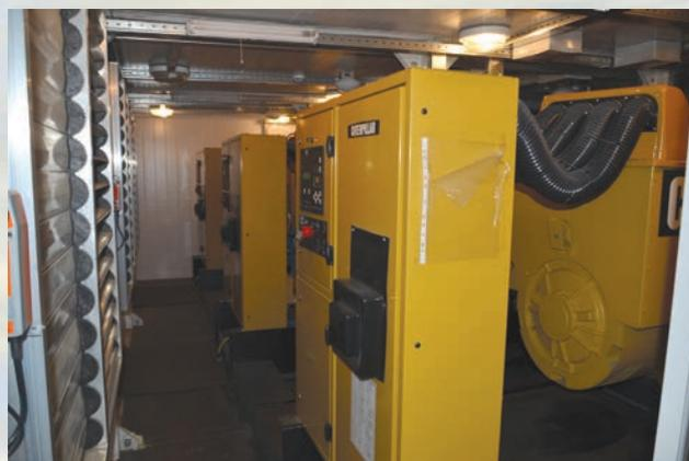
**Дизельная научно-исследовательской станции, один рабочий агрегат «Caterpillar» (256 КВт) и два резервных**
