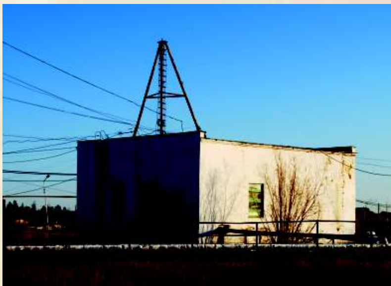
Рис. 1. Здание водозаборной скважины 1-Я, расположенной на территории микрорайона «Мерзлотка» г. Якутска.
