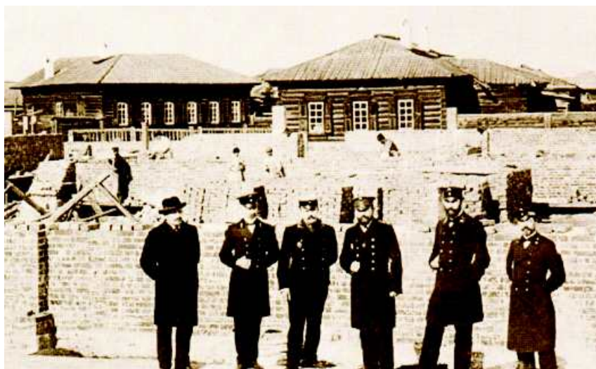
Губернатор на закладке кирпичного здания реального училища в г. Якутске (1908 г.).
