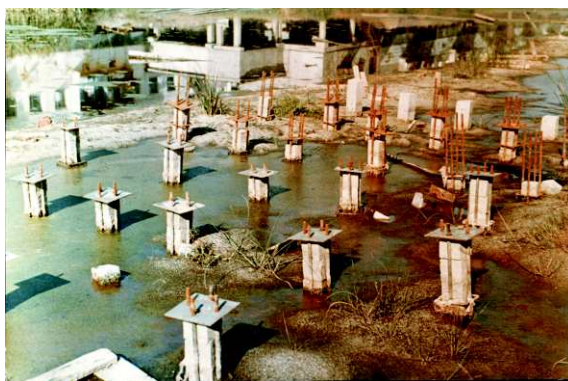
Экспериментальный полигон для исследования стойкости бетонных и железобетонных фундаментных конструкций, работающих в условиях минерализованных грунтовых вод и низких отрицательных температур в г. Якутске.
