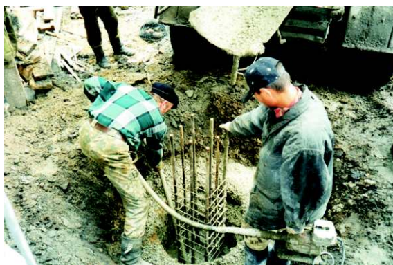
Устройство буронабивных свай, 2001 г.
