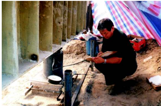
Натурные испытания свай ведет заведующий сектором ОиФ Егоров Г. Е.
