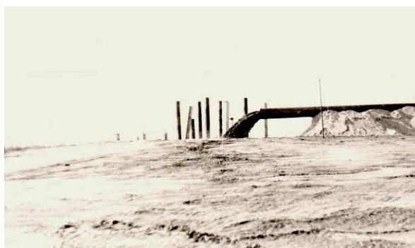
Гидромеханизированные работы на опытных полигонах.
