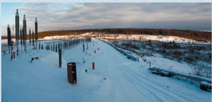
Рис. 2. Общий вид замораживающей системы на гидроузле р. Ирелях (октябрь 2011 г.)
