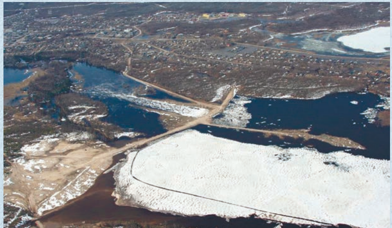
Рис. 12. Гидроузел на р. Матта, Горный улус (РС(Я))
