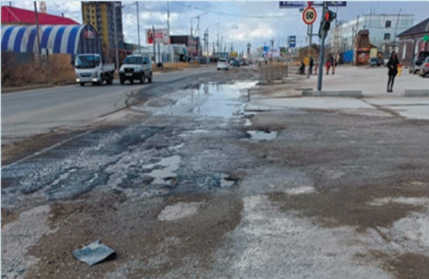
Разрушения асфальтобетонного полотна на дорогах г. Якутска (ул. Автодорожная, май 2023 г.)
