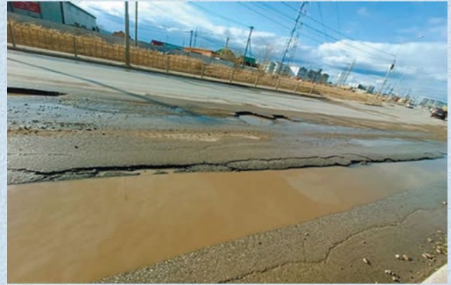
Разрушения асфальтобетонного полотна на дорогах г. Якутска (ул. Автодорожная, май 2023 г.)
