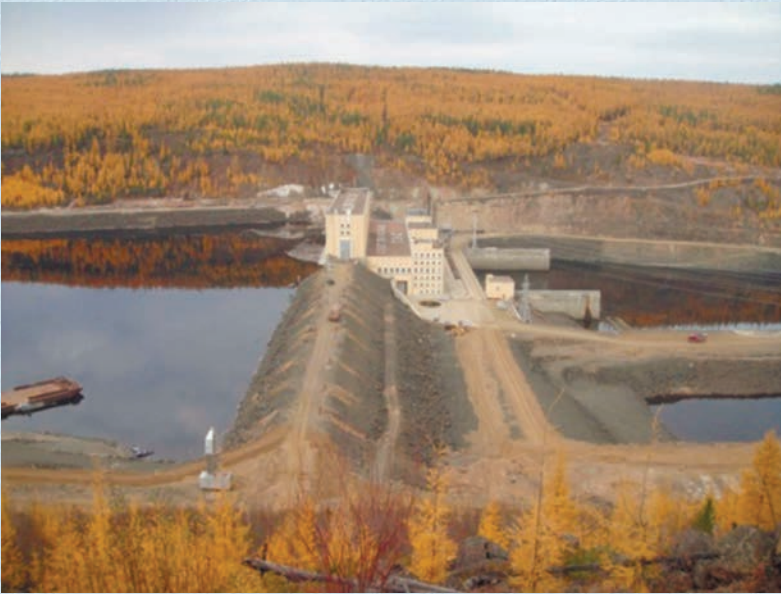
Рис. 5. Общий вид плотины на р. Вилюй. Светлинская ГЭС (ВГЭС – 3)
