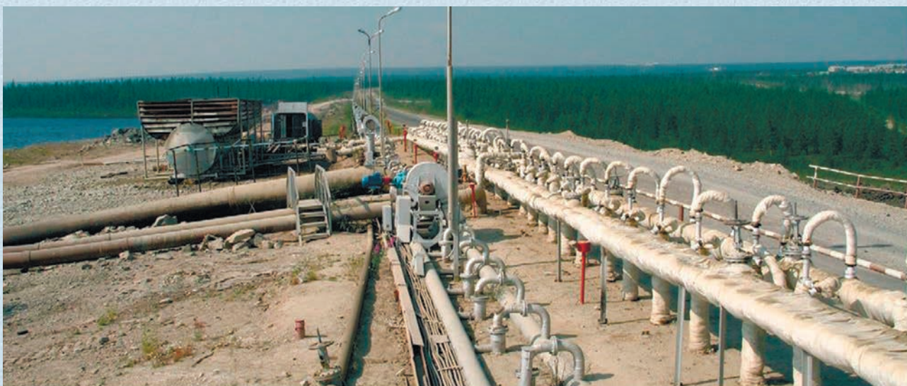
Рис. 4. Общий вид замораживающих систем на гидроузле р. Сытыкан
