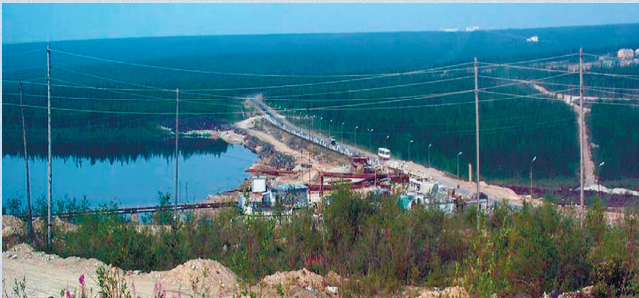
Рис. 3. Общий вид гидроузла на р. Сытыкан со стороны верхнего бьефа. Удачинский ГОК
