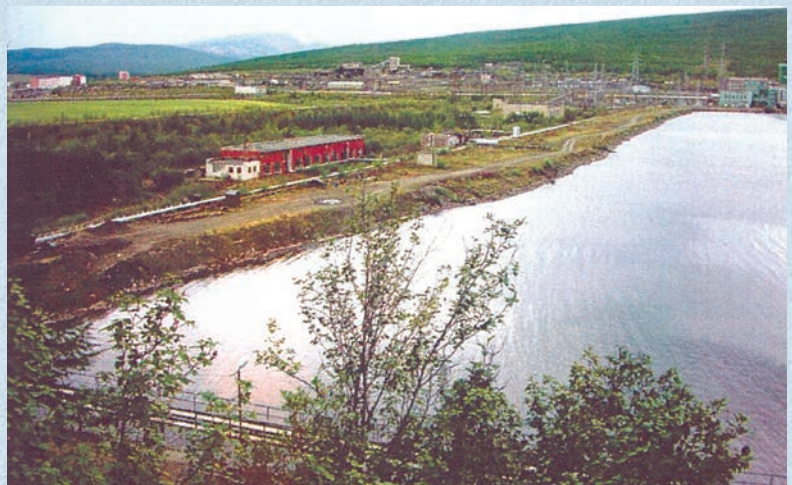
Рис. 13. Плотина на р. Мянунджа. Общий вид. Аркагалинская ГРЭС (Магаданская область)
