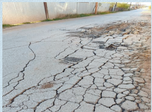
Проломы дорожной одежды с раздроблением асфальтобетона
