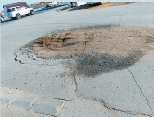
Проломы дорожной одежды с раздроблением асфальтобетона
