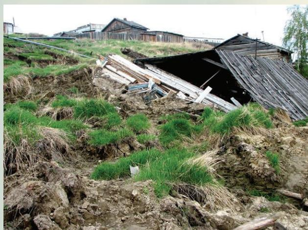
**Рис. 5. В результате произошедшего оползневых процесса от жилого дома, стоявшего под уступом террасы р. Лены, осталась только крыша (фото автора, г. Покровск, 20.09.2006 г.)**
