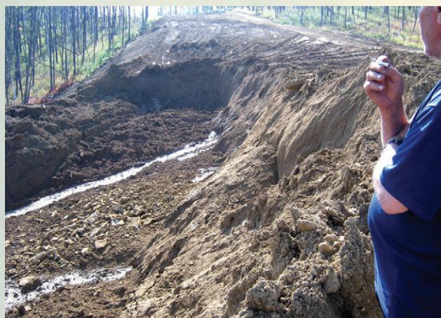
**Рис. 8. Сползание отсыпанной части земляного полотна строящейся автодороги «Амга» на ПК-266** (фото автора, 12.08.2014 г.)
