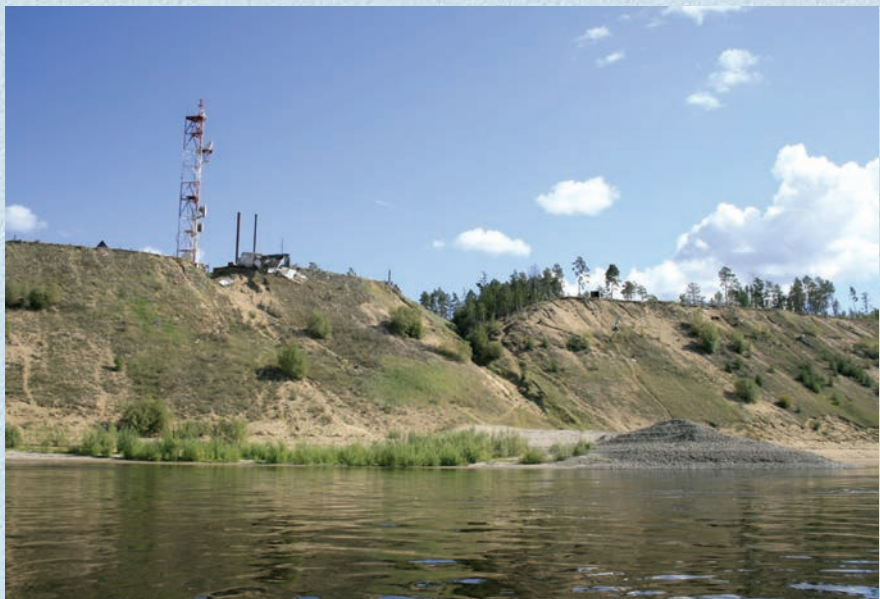
Размываемый берег (уступ бестяхской террасы р. Лены) выше пос. Нижний Бестях. Справа – берегоукрепительное сооружение
