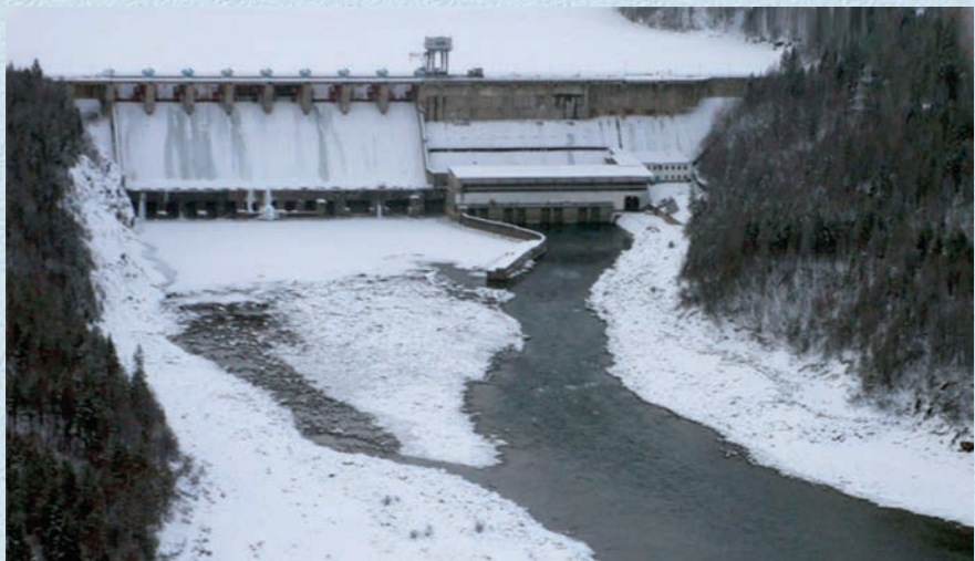
Плотина Мамаканской ГЭС и общий вид нижнего бьефа (фото с сайта www.mamges.ru )
