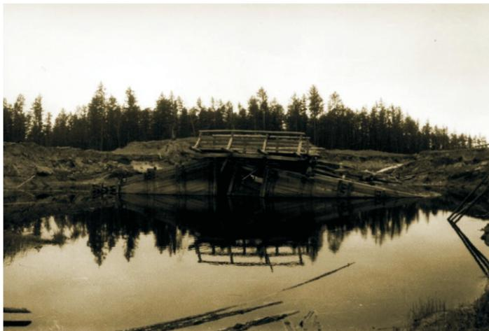
**Хоробутская мелиоративная система в Мегино-Кангаласском улусе РС(Я). Деревянный шлюз-регулятор № 4 сточно-обшивной конструкции, разрушенный паводком в 1971 г.**
