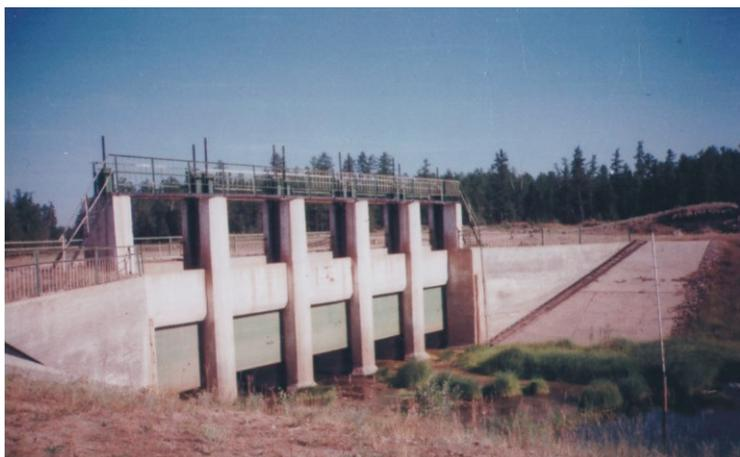
**Хоробутская мелиоративная система в Мегино-Кангаласском улусе РС(Я). Головной железобетонный водосброс на р. Суола – вид с верхнего бьефа.**
