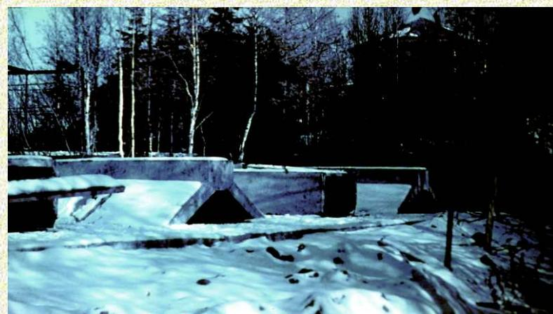
Рис. 5. Общий вид фундамента-оболочки с вентиляционными каналами в период строительства.
