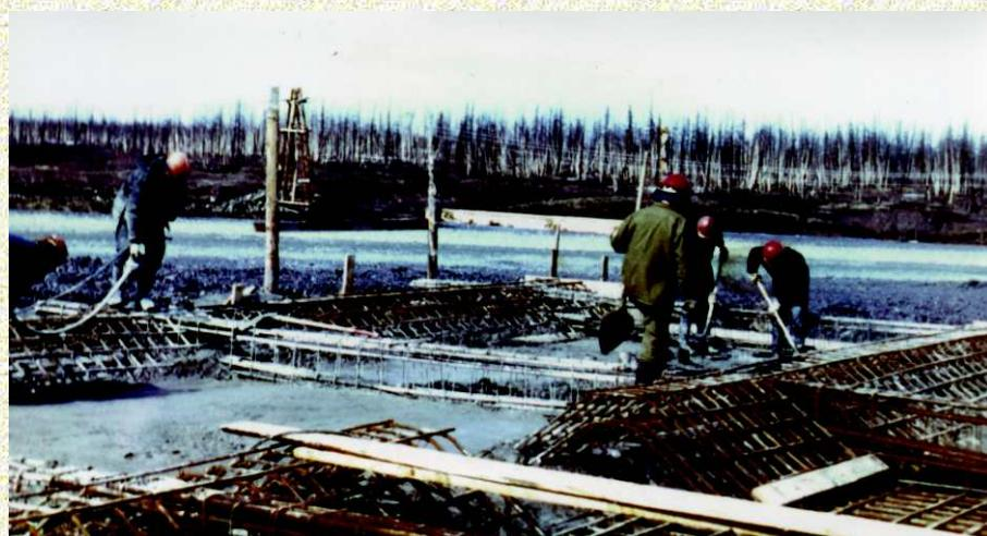
Рис. 2. Бетонирование фундамента-оболочки.
