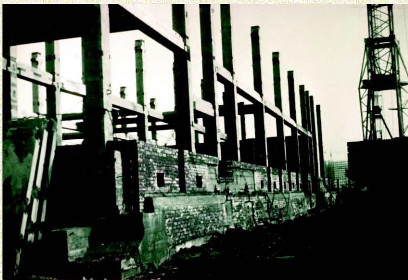
Рис. 3. Часть корпуса АБК на поверхностном фундаменте-оболочке в г. Норильске.
