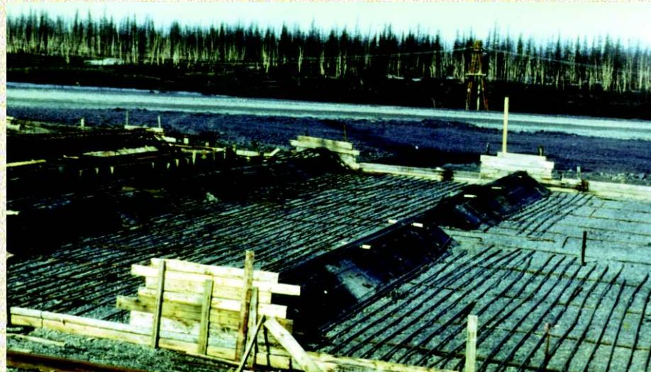
Рис. 1. Армирование фундамента-оболочки (панорама нулевого цикла).
