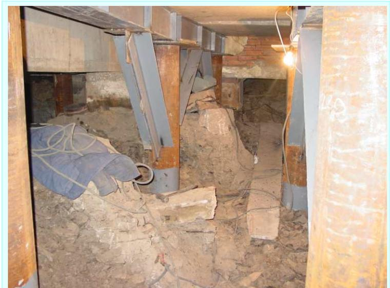
*Монтаж дополнительных стоек для укрепления фундамента аварийного здания.*
