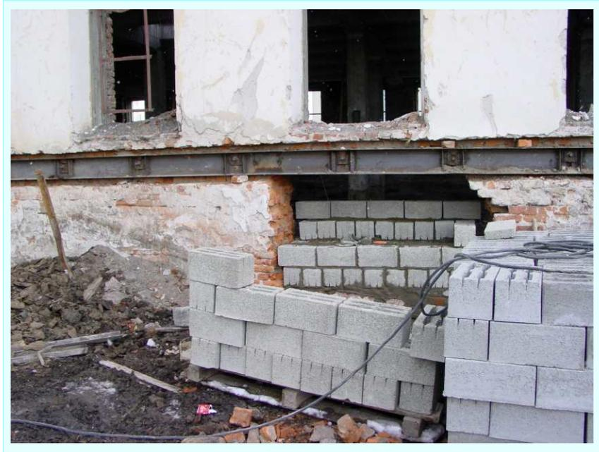
**Виды применяемых ремонтно-восстановительных работ: создание укрепительного металлического пояса и замена несущей части кирпичной кладки аварийного здания.**
