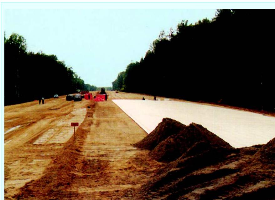
**Укладка пенополистирольных плит «Пеноплэкс», рекомендуемых конференцией для обеспечения морозоустойчивости дорожной конструкции автомобильных дорог в условиях Якутии.**
