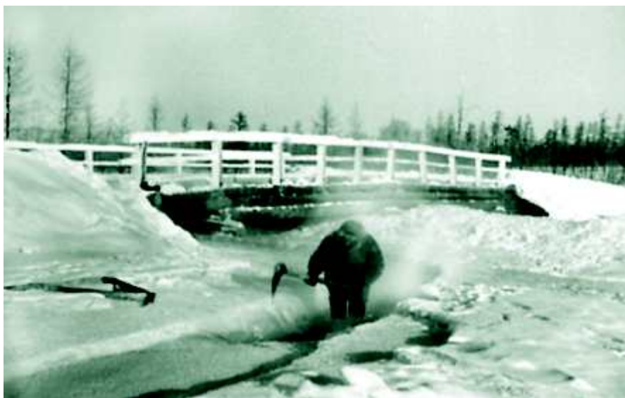
Устройство водоотводной канавы у моста на руч. Ики.
