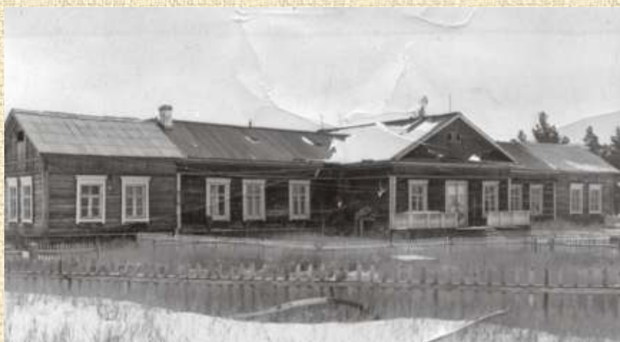
Здание Якутской научно-исследовательской мерзлотной станции Института мерзлотоведения им. В.А. Обручева АН СССР (Якутск, 1941-1956 гг.).
